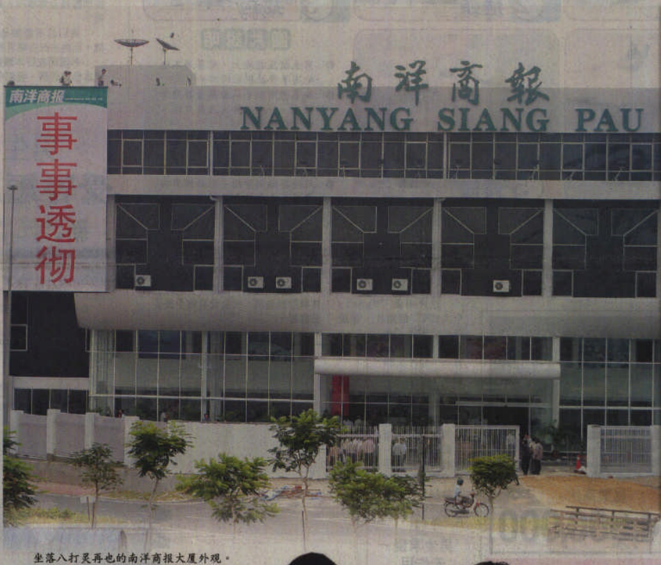
坐落八打灵再也的南洋商报大厦外观。
